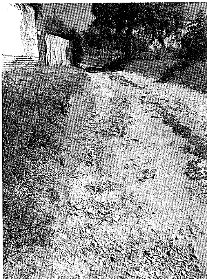
4. ábra Hosszanti csatornaszerű és lokális kimosódás az útpályában (Ady E. utca 1293 hrsz.)
