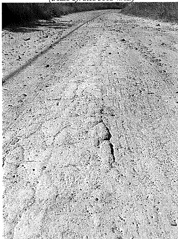
6. ábra Erős burkolati kipergések a tönkrement aszfaltburkolatú szakaszon (Dózsa Gy. utca 3862 hrsz.)
