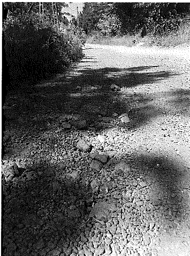
7. ábra Hosszanti csatornaszerű és lokális kimosódás a szilárd burkolat nélküli útpályában (Dózsa Gy. utca 3862 hrsz.)
