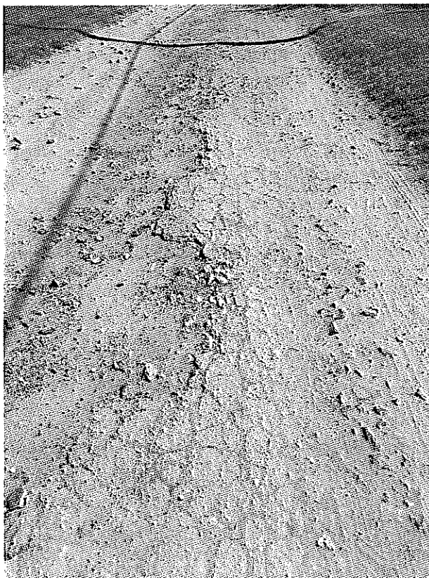
5. ábra Erős burkolati kipergések a tönkrement aszfaltburkolatú szakaszon (Dózsa Gy. utca 3862 hrsz.)
