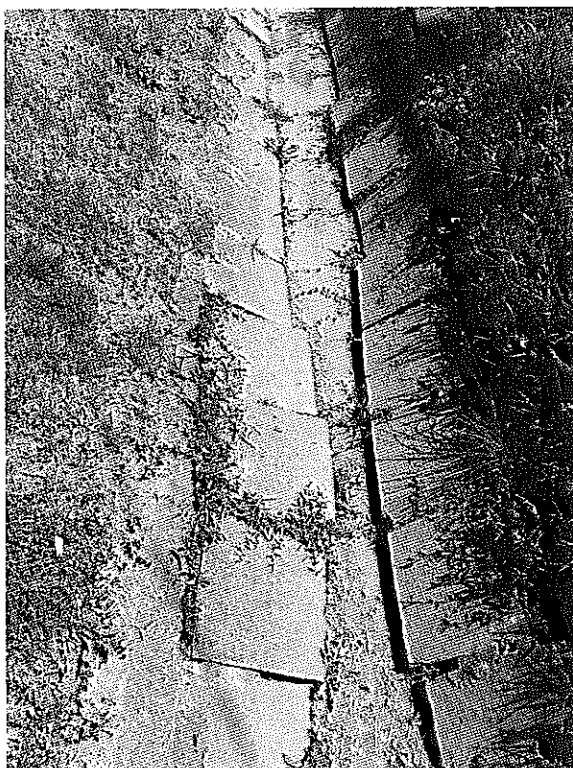
8. ábra Meglévő beton árokburkoló lapok lecsúszása (Bem utca 1442 hrsz.)
