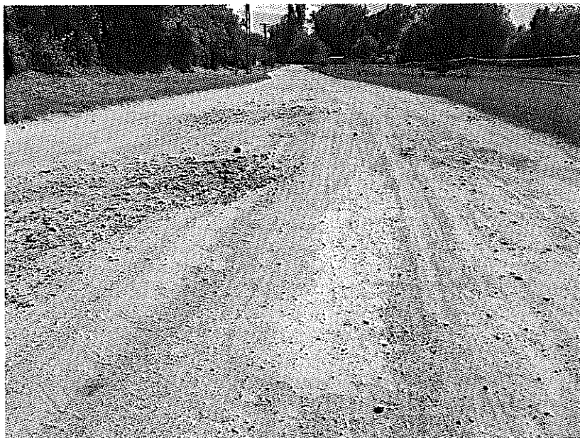
1. ábra Erősen kipergett és felszínre került burkolati rétegek (Névtelen.út 1412/6 hrsz.)
