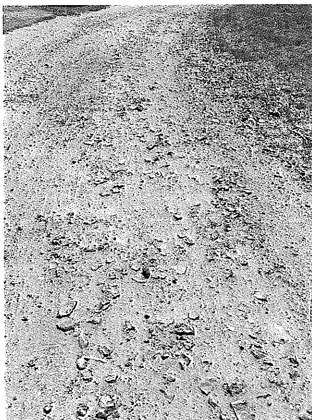
2. ábra Erősen kipergett és felszínre került burkolati rétegek (Névtelen.út 1412/6 hrsz.)
