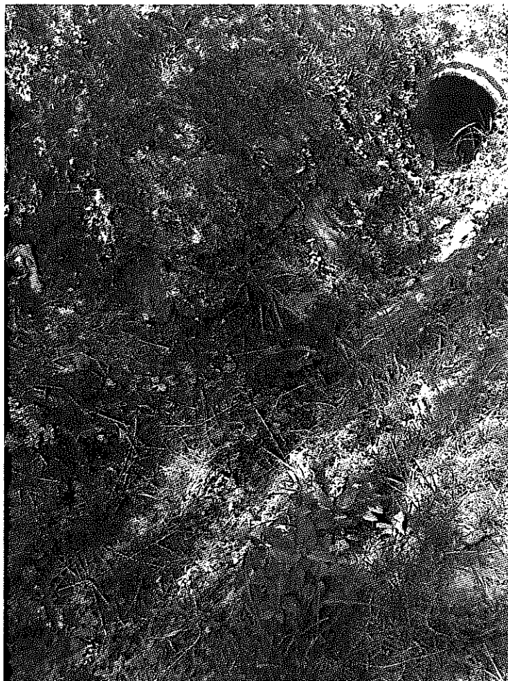
10. ábra Meglévő beton csőáteresz kitorkolásának környezetében az árokmeder károsodása (Bem utca 1442 hrsz.)
