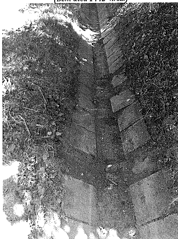
9. ábra Meglévő beton árokburkoló lapok lecsúszása illetve hiánya (Bem utca 1442 hrsz.)
